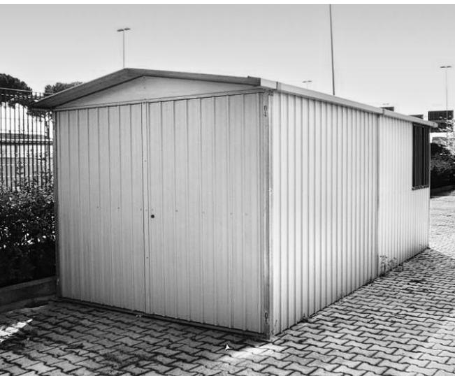
La struttura è costituita da telai realizzati con profili tubolari quadri di opportune dimensioni in acciaio zincato, rivestiti con lamiere doghettate ricavate da nastro di acciaio zincato e/o preverniciato dello spessore di mm. 0,4 ca.
